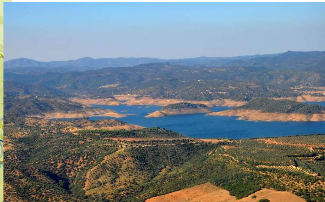
La retenue de Bornos après Arcos de la frontera
